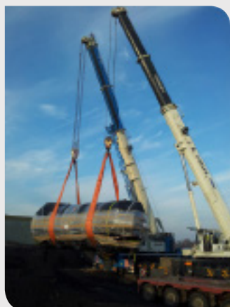
Ex : déchets volumineux et lourds (chaudières, fours aminatés).
