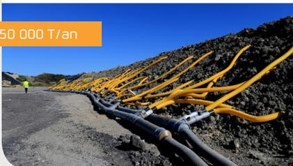
\* Biotraitement : Dépollution des terres souillées aux hydrocarbures par traitement biologique.
